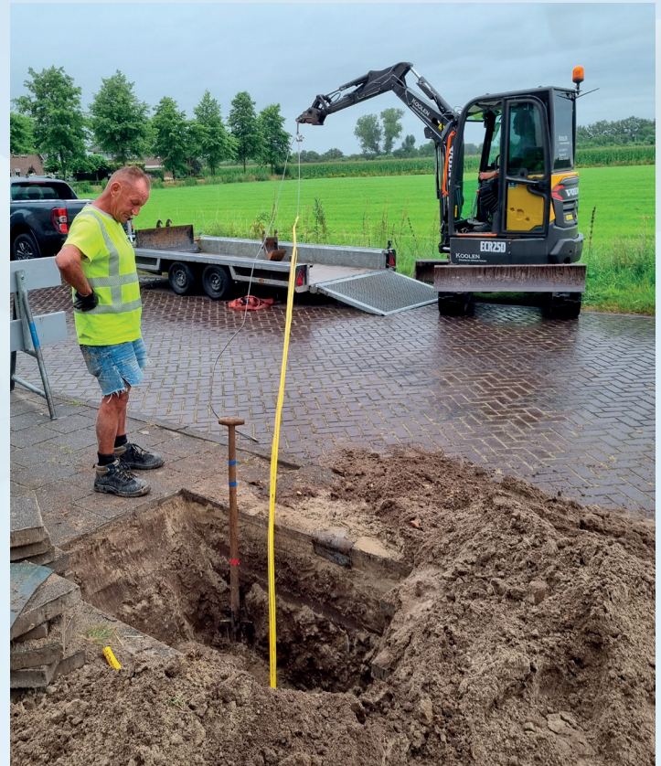
Onlangs werd aan de Oostmoer een woning afgekoppeld van het gasnet. We zullen dit de komende jaren steeds meer zien op weg naar een fossielvrij Nispén.
